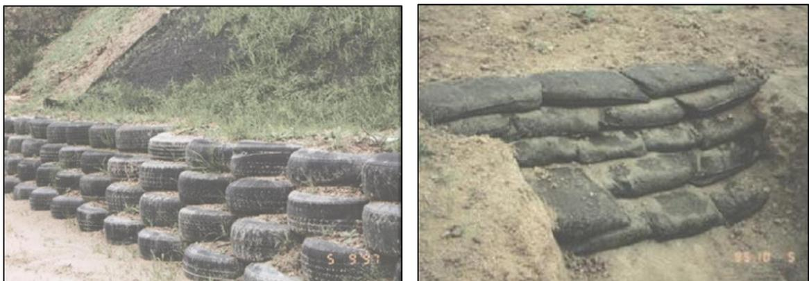
Figura 20. Tratamiento de control de taludes mediante muros de neumáticos en fase de estabilización y sacos rellenos (Francke *et al.*, 2004).
