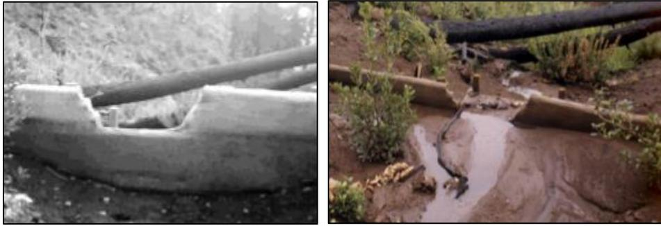
Figura 13. Secuencia de imágenes que muestran la acumulación de sedimentos en un dique luego de las lluvias (Navarro *et al.*, 2001).
