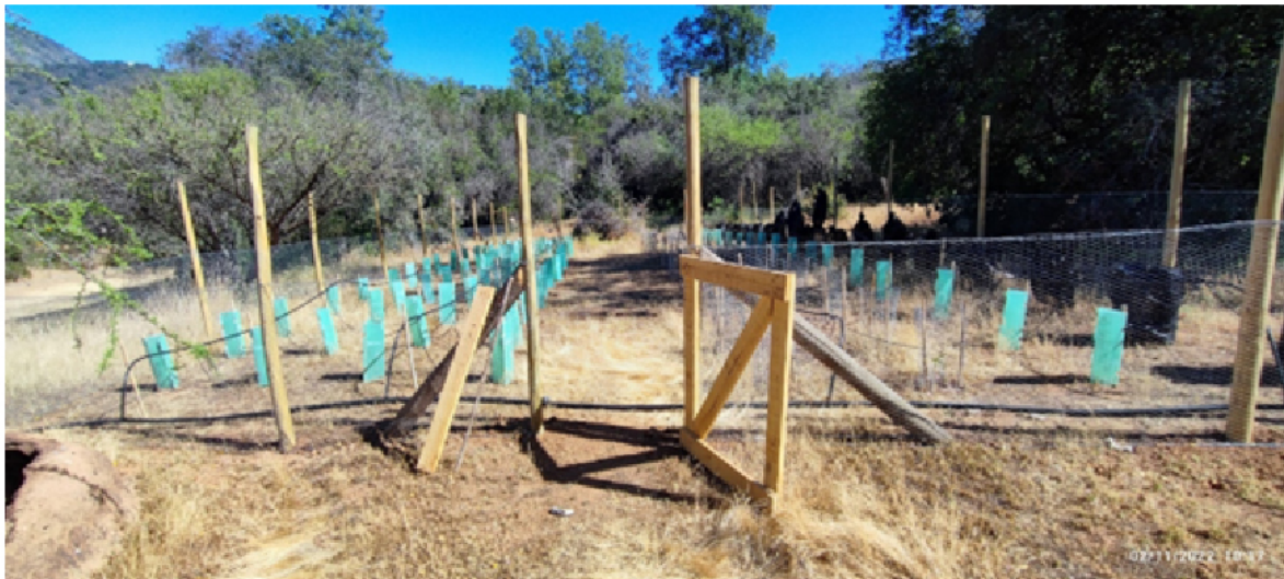
Figura 11. Instalación cerco perimetral de protección.
